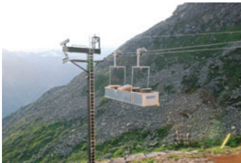
Fertige Materialseilbahn Warnsdorferhütte
