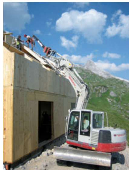
Bauarbeiten an der Franz-Fischerhütte
