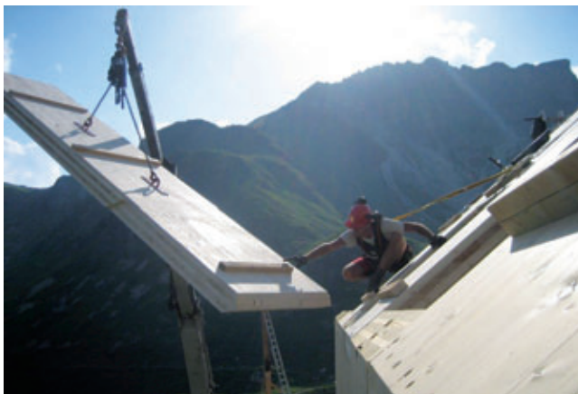
Bauarbeiten an der Franz-Fischerhütte
