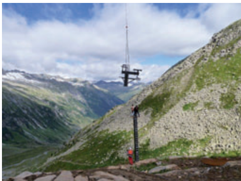
Bau Materialeilbahn Warnsdorferhütte
