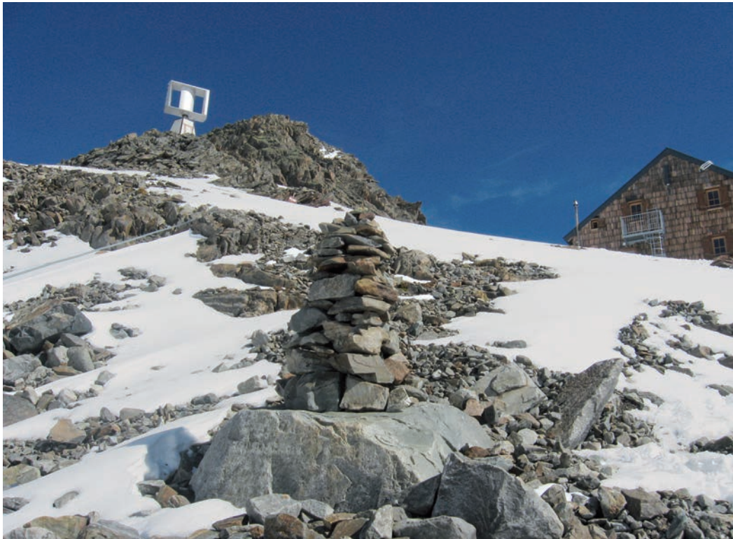
Abbildung 18: Rotor auf senkrechter Achse an der Müllerhütte/Stubaier Alpen. Neuentwicklungen im Bereich der Kleinwindkraftanlagen scheinen sich zu bewähren.
