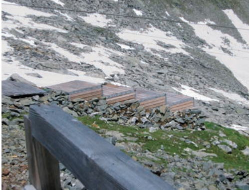
Abbildung 46: Auch der Stufenkomposter gehört zu den Kompostierungssystemen. Die Rotte wird nach einer Saison in die nächste Kammer weiterschaufelt.
