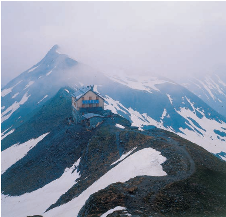
Abbildung 7: Das Niedersachsenhaus in der Goldberggruppe/Hohe Tauern stellte 1987 eine Musterhütte auf dem Gebiet der umweltfreundlichen Bauweise und Versorgung dar.
