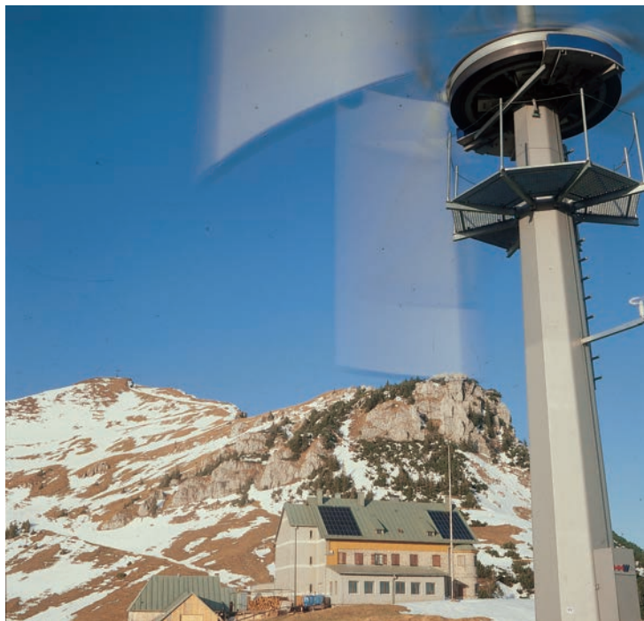
Abbildung 11: Das Rotwandhaus-Windrad in vollem Betrieb. Es war Bestandteil einer Hybridanlage aus Windkraft, Solarenergie und Motorstromgenerator, der aufgrund der erneuerbaren Energien seltener lief.
