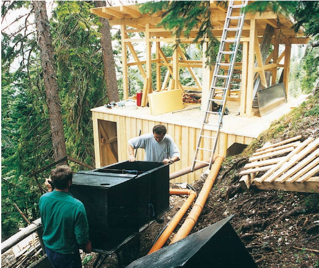
Abbildung 48: Einbau der Kompostierbehälter auf der Brunsteinhütte/Karwendel.
