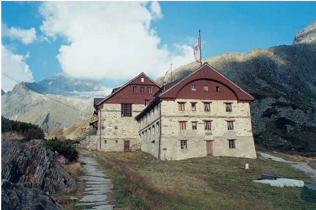
Abbildung 54: Berliner Hütte/Zillertaler Alpen; „dem Sturme Trutz, dem Wanderer Schutz“, das glaubt man gern, wenn man dieses Stützpunkts gewahr wird. Die Energieversorgung leistet ein bewährtes Kleinwasserkraftwerk.
