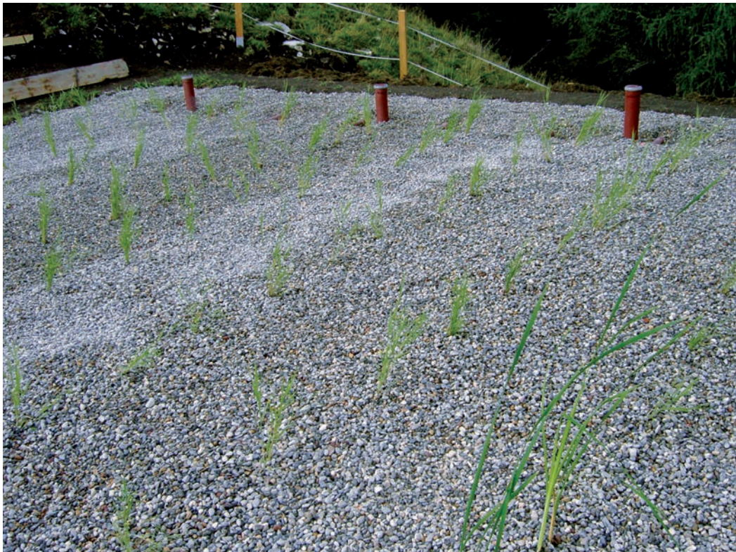
Abbildung 36: Der bepflanzte Bodenfilter am Purtschellerhaus in den Berchtesgadener Alpen
