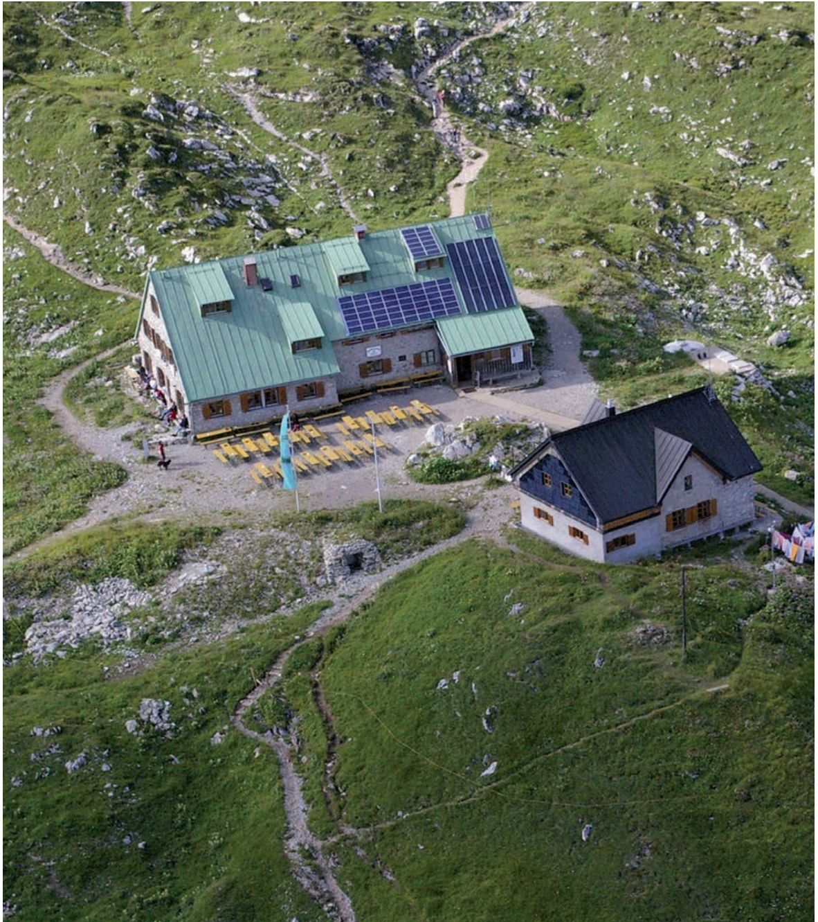
Abbildung 23: Die Mindelheimer Hütte hat alles, was einen umweltgerechtern Betrieb ausmacht: ein durchdachtes, in der Praxis bewährtes Energiekonzept, funktionierende Anlagen und einen technikversierten, engagierten Wirt.
