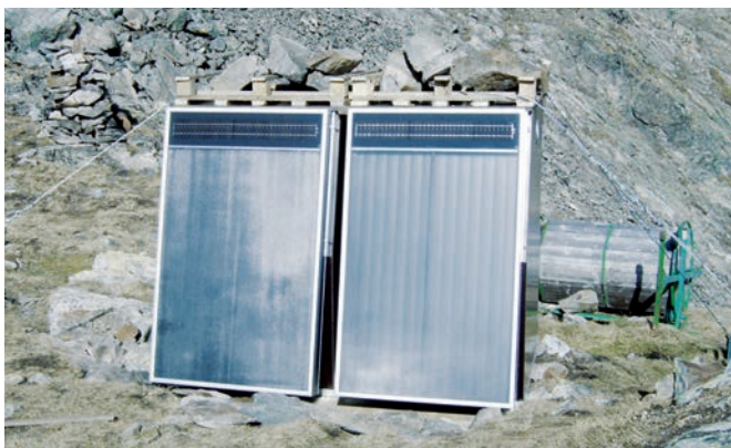
Abbildung 45: Besonders in größeren, kühleren Höhenlagen leisten Solarkomposter wertvolle Dienste wie hier auf der Kaunergrathütte/Öztaler Alpen.
